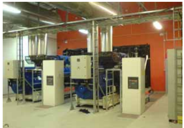
Figur 12-11 Reservekraftanlegg
